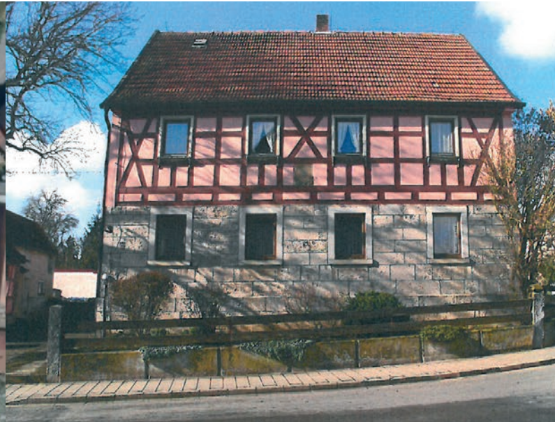
Ansicht Hauptgebäude - Am Dorfplatz
