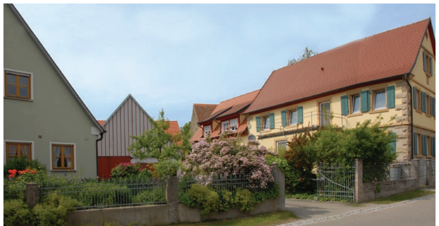
Schweinsdorf, Neues Wohnen im Altort durch Sanierung und Erweiterung eines innerörtlichen Hofanwesens
